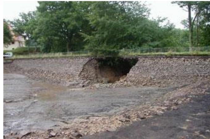
*Digue rompue par un renard hydraulique*
